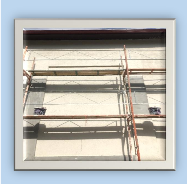
Resim 29 - 30 : Dış Cepheye XPS Levha Uygulanması Yapılması
