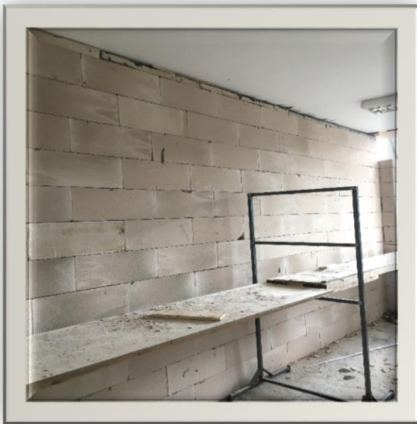
Resim 9 - 10 : Gazbeton ile Yeni Duvar Örülmesi
