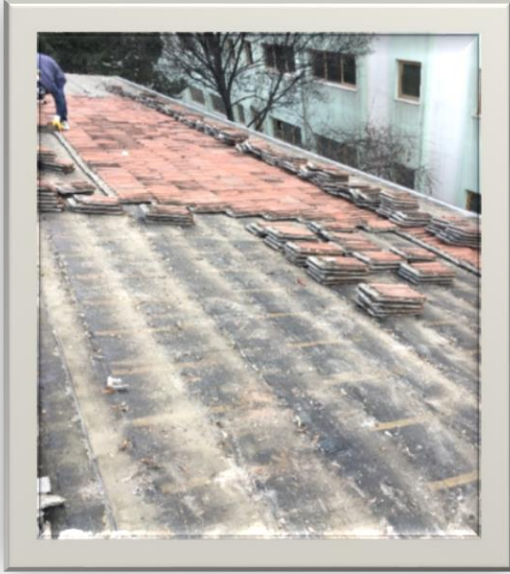
Resim 1 : Çatı Örtüsü Sökümü
