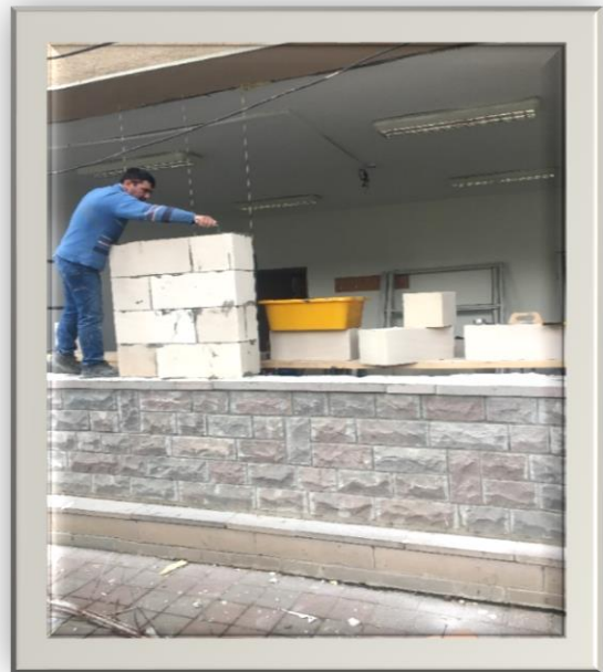
Resim 9 - 10 : Gazbeton ile Yeni Duvar Örülmesi
