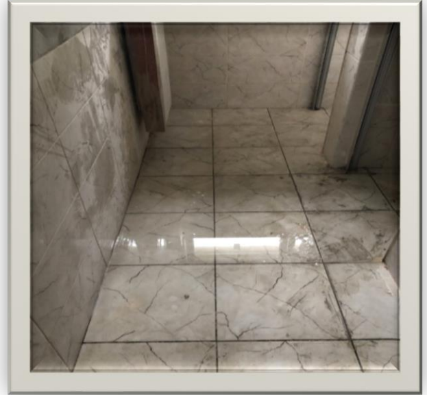
Resim 25 - 26 : Duvarlara Seramik Uygulaması Yapılması
