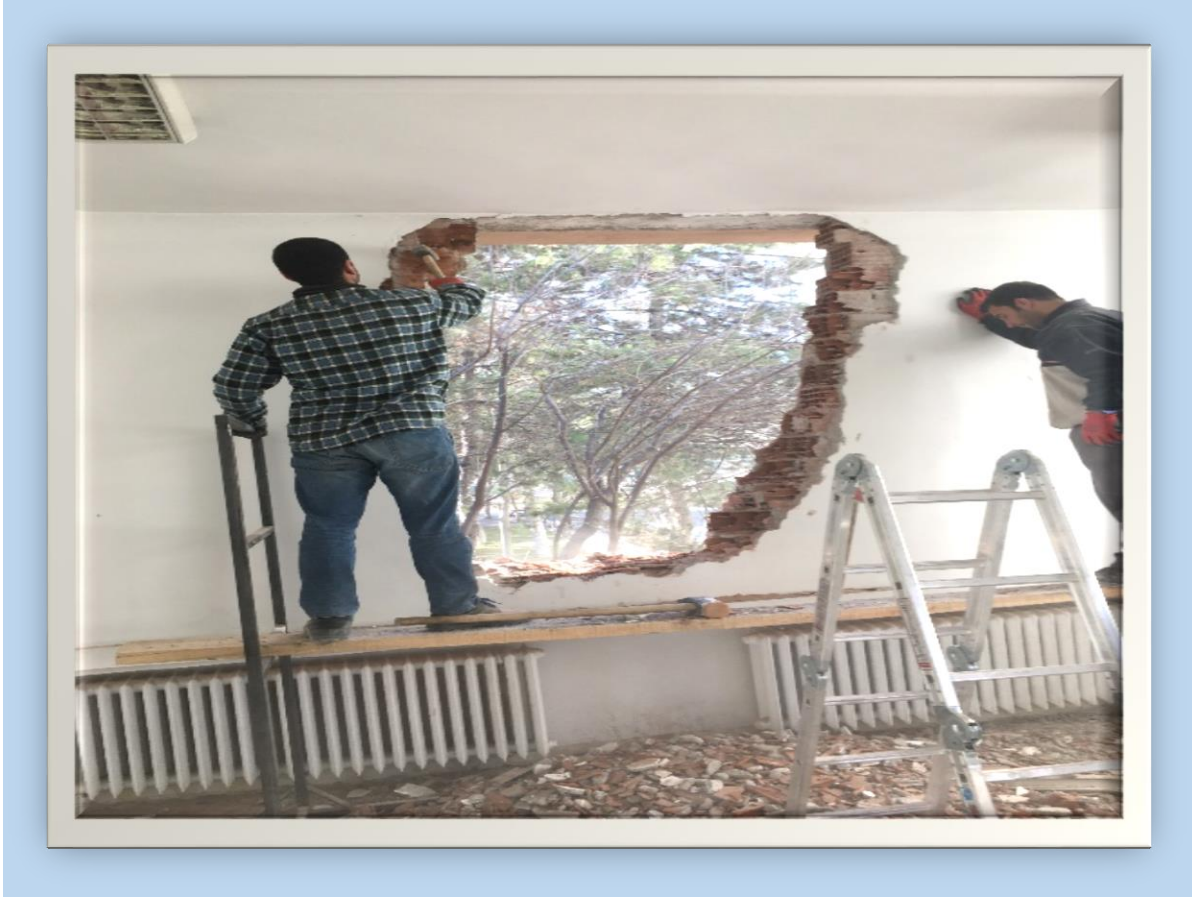
Resim 7 - 8 : Projede Yıkımı Öngörülen Duvarların Yıkılması
