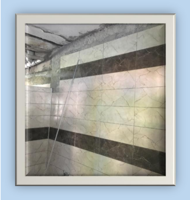
Resim 25 - 26 : Duvarlara Seramik Uygulaması Yapılması
