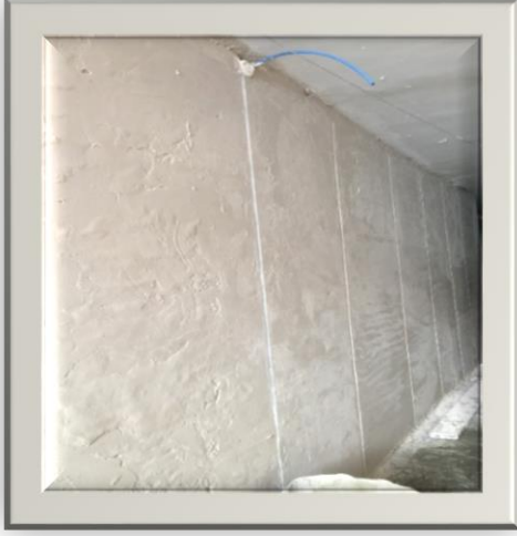
Resim 11 : Alçı Sıva Yapılması
