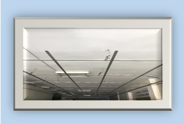
Resim 21- 22 : Alüminyum Asma Tavan Uygulaması Yapılması Mevcut şap betonları ve seramikler kırılarak yeni uygulama için hazır hale getirilmiş ve sonrasında döşemelere tesviye
