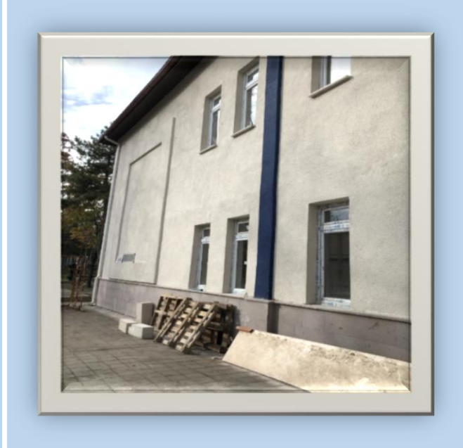
Resim 29 - 30 : Dış Cepheye XPS Levha Uygulanması Yapılması
