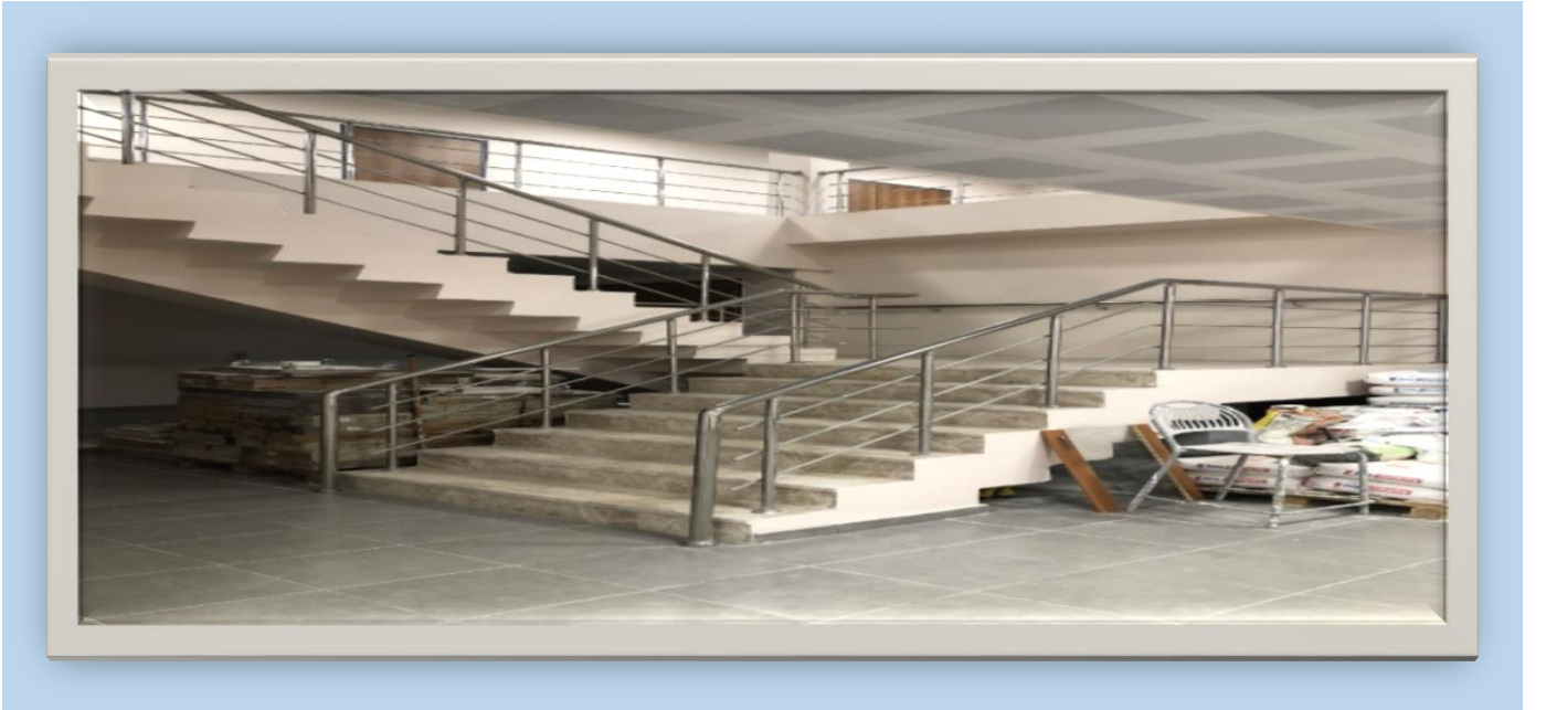
Resim 33 : Mermer Levha Kaplaması Ve Korkuluk Uygulaması
