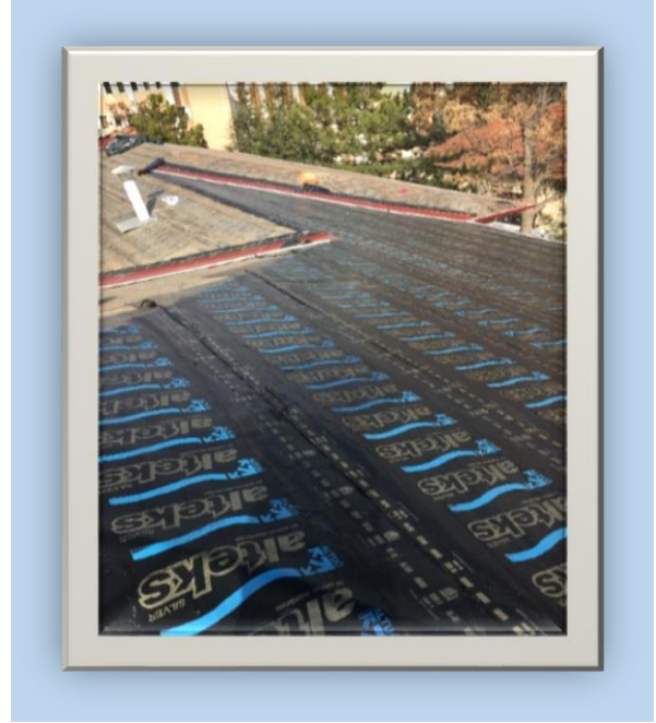
Resim 2 : Su Yalıtımı Uygulaması
