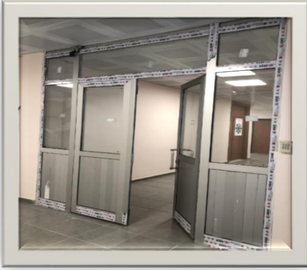
Resim 19 : Alüminyum Kapı Uygulaması
