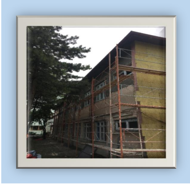
Resim 27 : Yalıtım Uygulaması Yapılması
