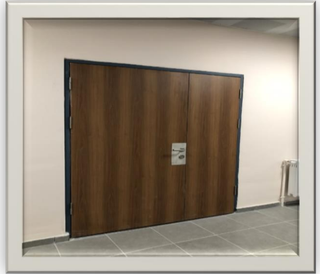
Resim 18 : Yeni Kapı Kanadı Takılması
