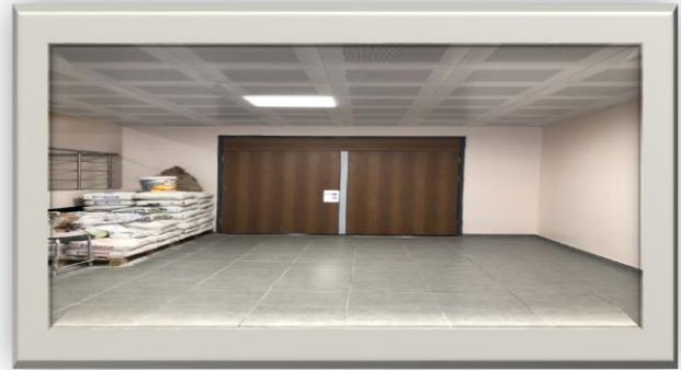
Resim 21- 22 : Alüminyum Asma Tavan Uygulaması Yapılması Mevcut şap betonları ve seramikler kırılarak yeni uygulama için hazır hale getirilmiş ve sonrasında döşemelere tesviye
